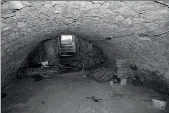
Abb. 2: Blick von Nordosten durch den Gewölbekeller auf den sekundär eingebrochenen zweiten Eingang vom Hof (Dezember 2012)
